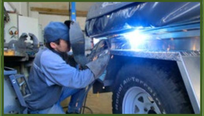
▲ Schweißarbeit: Der Aufbaurahmen und die Befestigung des Klappzelts wurden speziell für das Projekt hergestellt.
