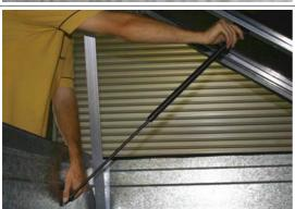
Sobald beide Halterungen fixiert sind, können sie die Gasdruckfedern einklicken. (Die Zylinder müssen nach oben zeigen.)
