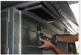
Sobald Sie mit der Position des Zeltes zufrieden sind, können Sie das Zelt mit dem Scharnier von unten verbinden. Hierzu bohren Sie Löcher der Größe Ihrer Nieten von unten durch das Scharnier und den Rahmen. Bitte Bohren Sie nur durch die erste Wand des Rahmengestänges und nicht vollständig durch den Zeltboden.
