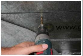
Bohren Sie die nötigen 6mm Löcher in die Seitenwände um die Halterungen später zu fixieren.
