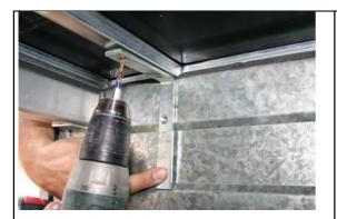
Fixieren Sie einen Winkel an jede Stahlstrebe des Zeltrahmens im inneren des Anhängers.
