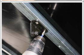
Entfernen Sie die Gasdruckfedern und fixieren Sie die Halterungen an der markierten Position mit Bohrschrauben im Zeltrahmen.
