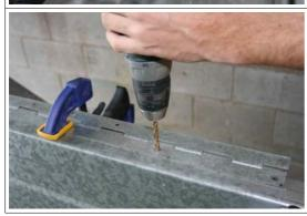
Bohren Sie Löchern mit maximal 10cm Abstand durch das Scharnier und die Seitenwand Ihres Anhängers.
