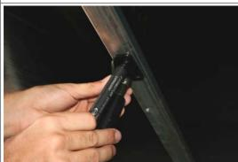
Befestigen Sie die Halterungen an den Gasdruckfedern und markieren sie deren gewünschte Position am Zeltrahmen.
