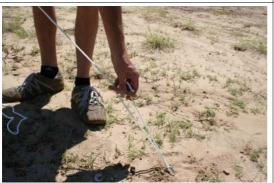
Unsere Abspannseile sind mit einem Spannmechanismus ausgestattet. Formen Sie eine Schlaufe und fixieren Sie diese mit Erdhacken am Boden.
