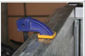
Platzieren Sie das Scharnier im geöffneten (nicht zusammengefalteten) Zustand auf die Seitenwand Ihres Anhängers und fixieren Sie es mit Klemmen.
